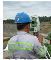
Gambar 2.1.2 Penggunaan Total Station
